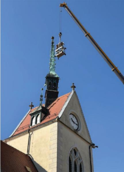
Als Ursache für diesen stellte sich ein Riss in der Blechabdeckung an der Durchführung der Stange des Turmkreuzes heraus. Dadurch konnte im Laufe der Zeit Wasser eindringen, wodurch der „Kaiserstiel“, eine senkrechte Holzstange in welcher das Metallkreuz befestigt wird, angefault und abgeknickt war.
